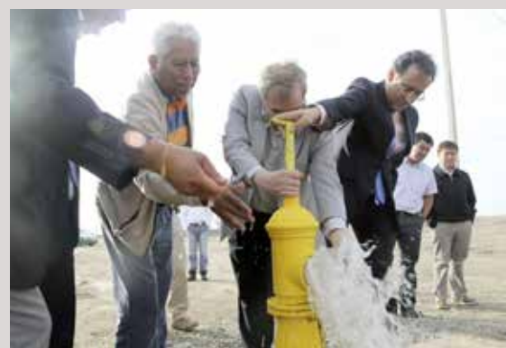
Planta desaladora para poblado de Michilla
